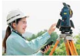
県内の建設現場で活躍する女性
