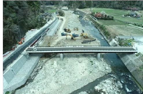
山国川河川改修工事状況
