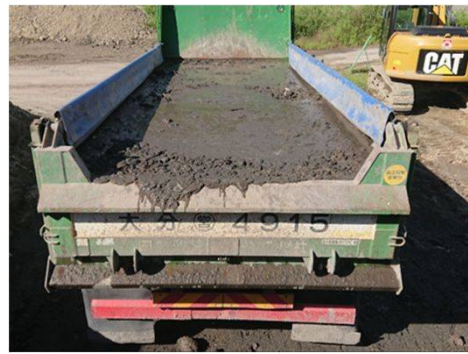
掘削土運搬状況
