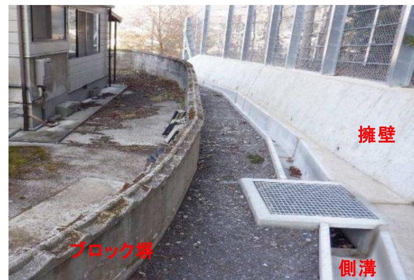
写真②(施工後)
