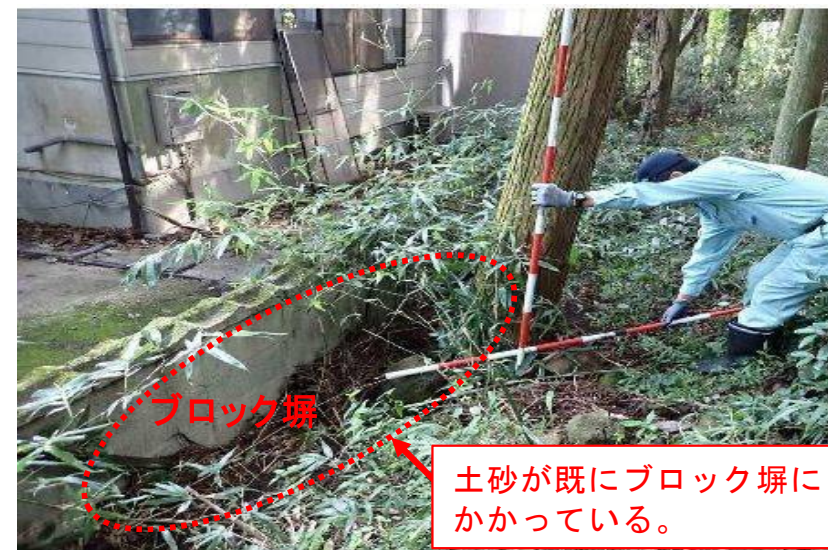
写真①(施工前)
