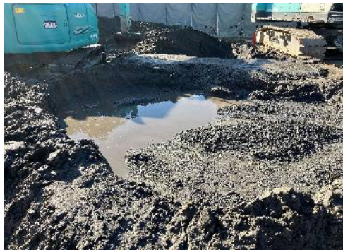
掘削土仮置き状況
