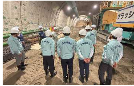
国道212号道路改築事業(日田山国道路)
