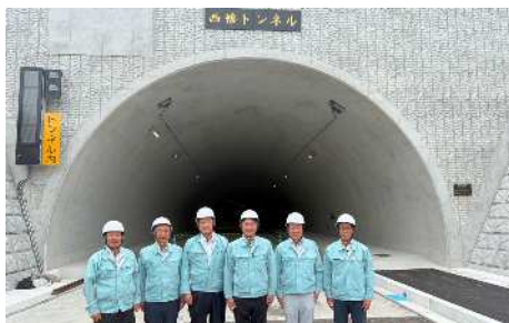
国道217号（戸穴バイパス）道路改良事業
