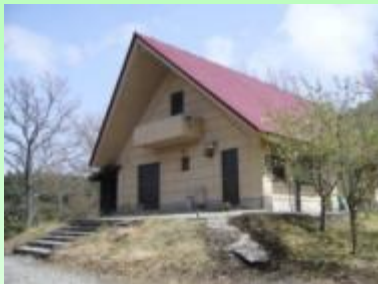
管理棟（事務室・用具倉庫）
