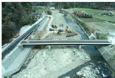
山国川河川改修工事状況
