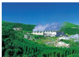
地熱発電設備容量 174千kW (R3年度)
