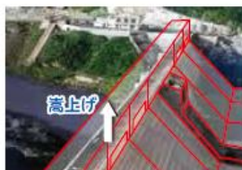
安岐ダムの再生(国東市)
