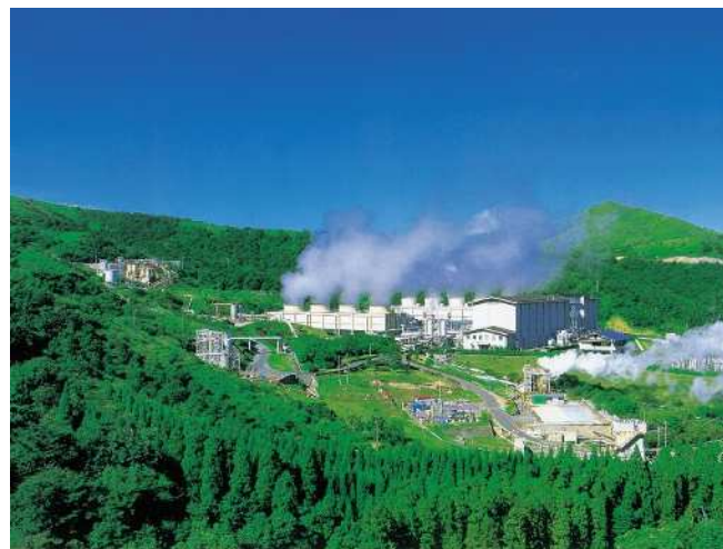
八丁原発電所（九重町）
