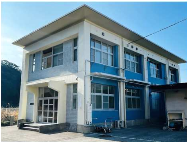
写真1 リニューアルした魚病棟の外観
