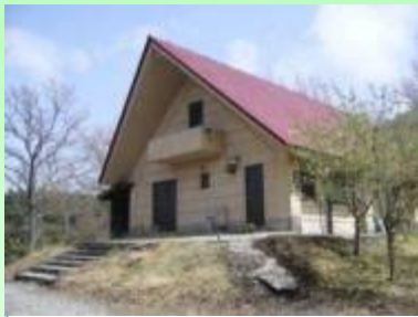
管理棟 (事務室・用具倉庫)
