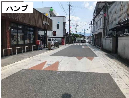
図表 3-9 生活道路内における整備事例(物理的デバイスの設置)
