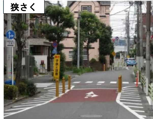
図表 3-9 生活道路内における整備事例(物理的デバイスの設置)
