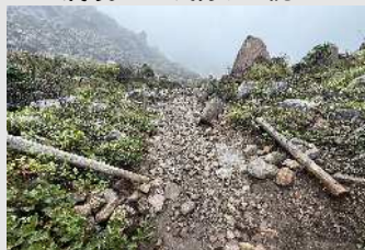
腐食により抜けた杭
