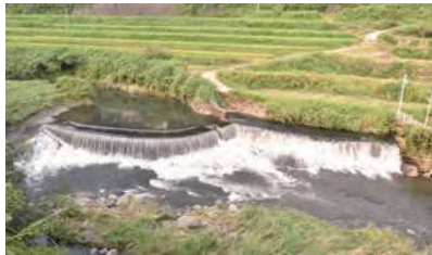
「神田頭首工」(城原井路)
