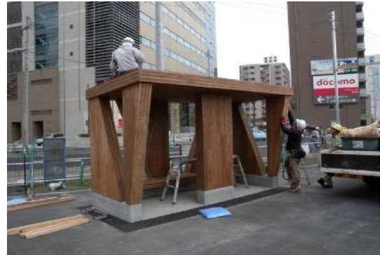
CLT実証棟施工見学会
