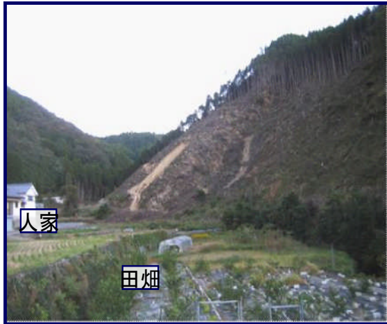
施工前（平成18年度）
