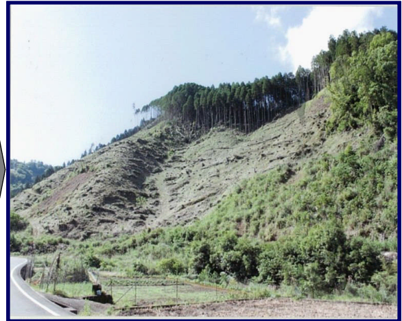
施工後（平成21年度）
