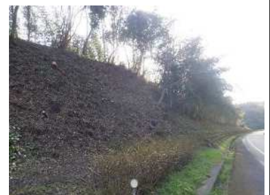
【大分空港道路支障木伐採】
