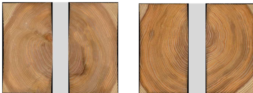
写真-4 2丁取り 50 の断面（養生後）
