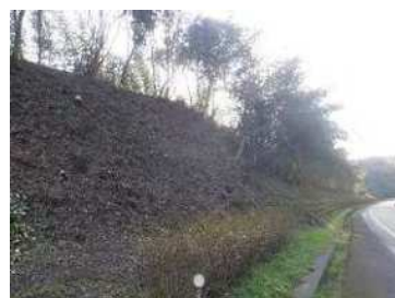
【大分空港道路支障木伐採】
