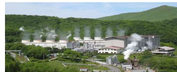
九電みらいエネルギー(株)八丁原発電所
