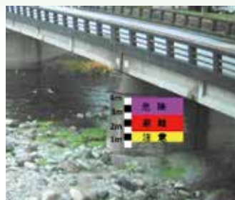
防災情報の充実・強化 (量水標設置)
