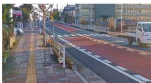
横断歩道前後のカラー舗装による視認性向上 国道213号(国東市)
