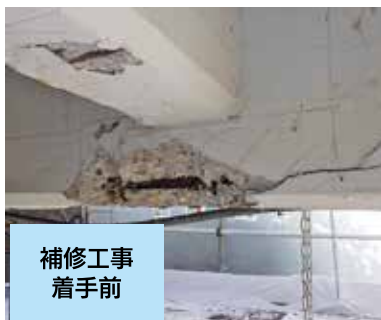
橋梁上部工(梁部分)の補修(断面修復工)による長寿命化 国道197号 江ノ脇橋(大分市)
