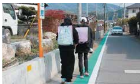
カラー舗装による歩行者分離対策 臼杵大南線(大分市)
