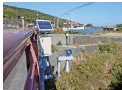
危機管理型水位計の設置
