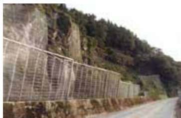
のり面対策 国道502号(豊後大野市)
