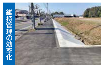
道路のり面の防草対策
