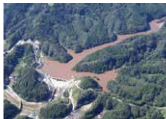
満水状態となった玉来ダム (令和4年 台風14号)
