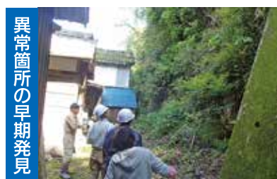
出水期前の点検
