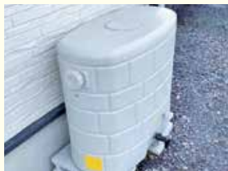
雨水貯留タンクの設置事例 [出典:国土交通省ホームページ]
