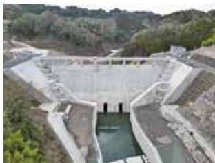
完成した玉来ダム
