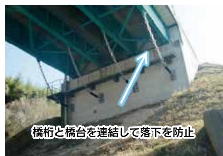
橋梁の落下に対する安全性の確保 糸原杵築線 松ヶ尾橋(杵築市)
