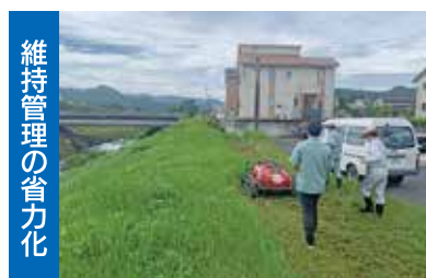
ラジコン草刈機の使用
