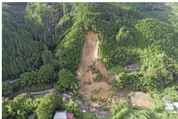
令和5年の梅雨前線豪雨(2023年)による被害状況 畑倉地区(由布市)
