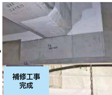
橋梁上部工(梁部分)の補修(断面修復工)による長寿命化 国道197号 江ノ脇橋(大分市)
