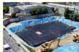
施工中(地下の状況)
