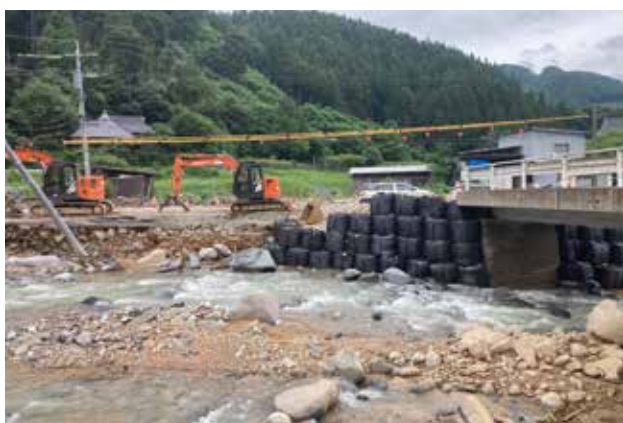
建設業協会による応急対応状況 小野川(日田市)
