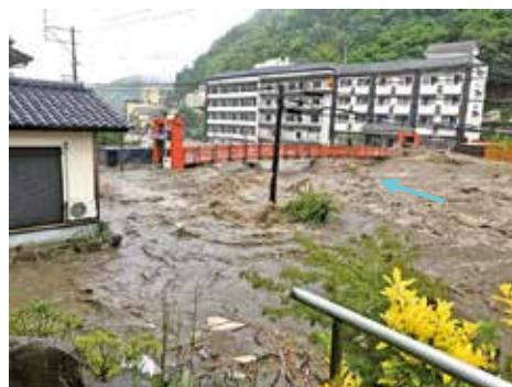
玖珠川のはん濫による浸水状況 (2020年7月 日田市天ヶ瀬温泉街)
