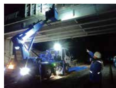
地域一括発注による線路を跨ぐ橋梁（跨線橋）の点検実施状況
