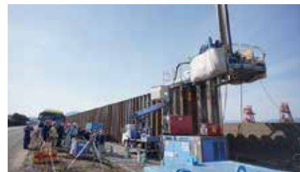
大分コンビナート護岸かさ上げ状況
