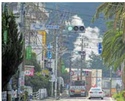
湯けむり景観を阻害する電柱類 国道500号(別府市)
