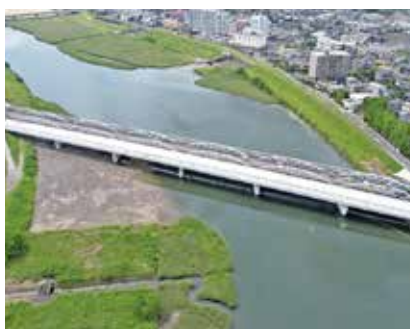
国道197号鶴崎拡幅 乙津橋(大分市)
