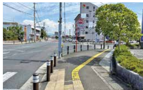
防護柵設置による交通安全対策 豊後高田国東線(豊後高田市)
