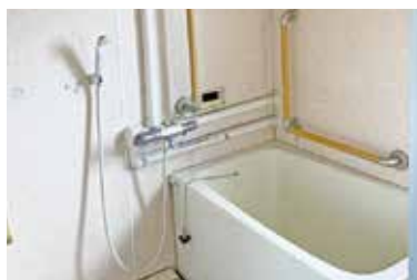
手すりの設置による浴室のバリアフリー化 下郡団地(大分市)
