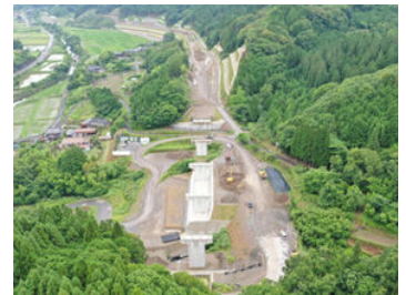
整備が進む三光本耶馬溪道路 (青の洞門・羅漢寺IC～本耶馬溪IC間)
