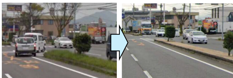
防草処理 (中判田下郡線:大分市)
