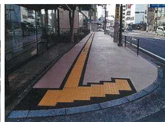
視覚障害者用誘導標示の設置 (日田玖珠線:日田市)
