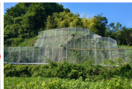
落石防護網の設置 (小川穴井迫線:竹田市)
