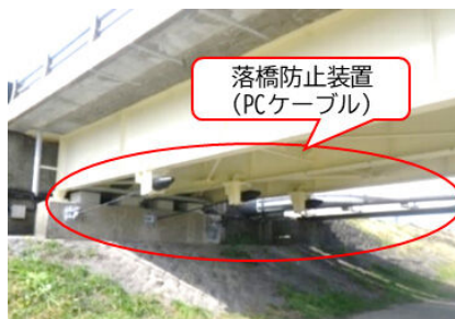
落橋防止装置の設置 (大分白杵線 高田橋:大分市)
