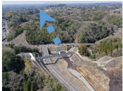
整備が進む竹田阿蘇道路 (竹田 IC 付近)
