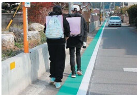
路肩のカラー舗装化 (臼杵大南線:大分市)
