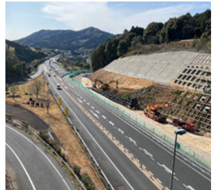
整備が進む東九州自動車道 (臼杵 IC 付近)
