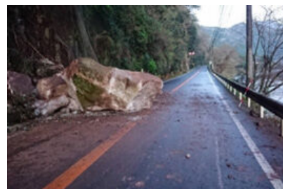
落石による通行止め (国道212号：中津市)
