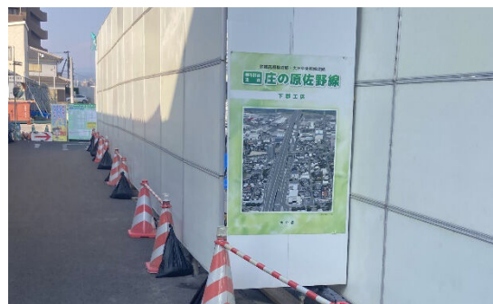
工事現場における完成予想図の掲示 (〔都〕庄の原佐野線:大分市)
