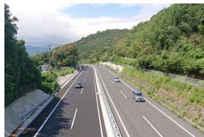
大分空港道路4車線化済区間の状況
