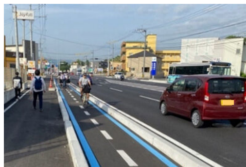
歩道・自転車道の整備状況 （国道442号 宗方拡幅：大分市）
