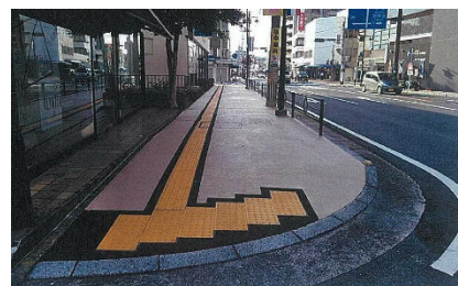
視覚障害者用誘導標示の設置 (日田玖珠線:日田市)
