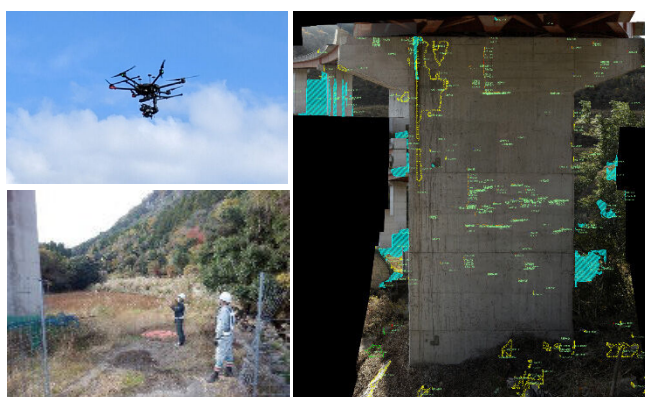
ドローン撮影を用いた橋梁点検
