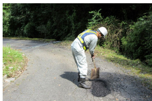
道路パトロールによる緊急対応状況
