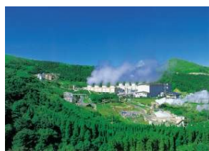
地熱発電設備容量 174千kW (R3年度)
