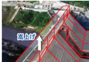
安岐ダムの再生(国東市)
