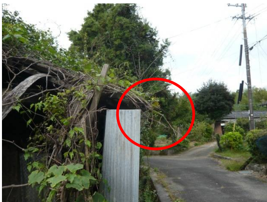
枝等が道路にはみ出ししている
