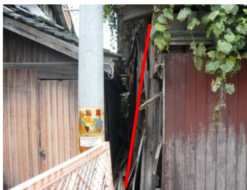
柱が傾斜している
