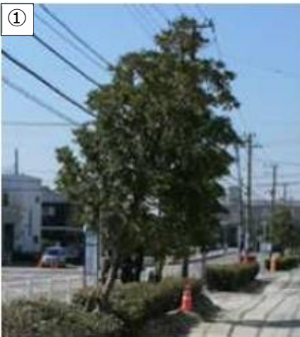
地震液状化による傾斜
