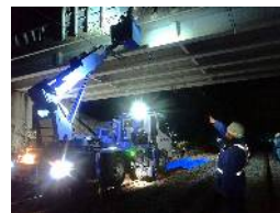
【跨線橋点検実施状況】
