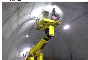
【高所作業車を用いた作業員による近接目視】
