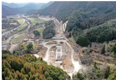
整備が進む中津日田道路（三光本耶馬溪道路）
