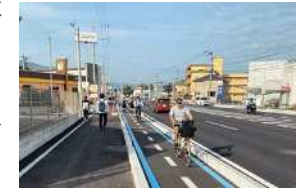
自転車通行空間の整備状況 （国道442号・大分市）
