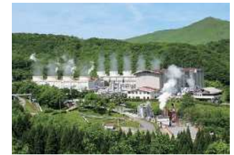
九電みらいエナジー株式会社八丁原発電所
