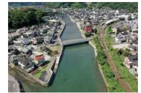
河川改修が完了した津久見川
