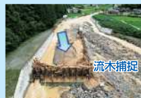
小野川(日田市)の流木捕捉(R5梅雨前線豪雨)
