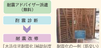
「木造住宅耐震化」補助制度 耐震化の一例(筋交い)
