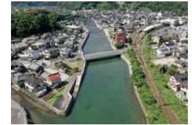
河川改修が完了した津久見川
