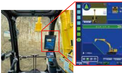
ICT建設機械による施工
