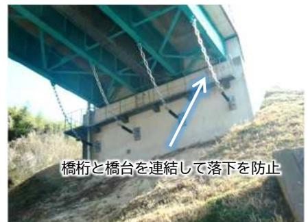
橋桁と橋台を連結して落下を防止
