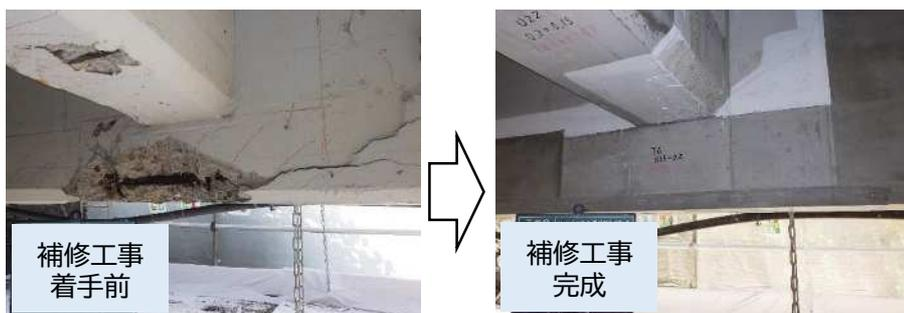
橋梁上部工(梁部分)の補修(断面修復工)による長寿命化
