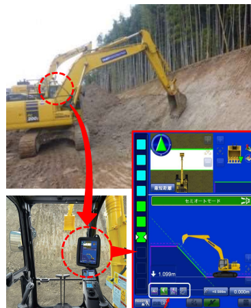
ICT建機での施工
