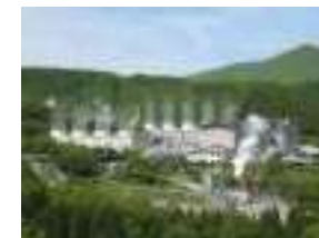
九州電力(株)八丁原発電所
