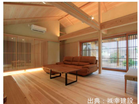
図 3-2-10 地域材の床とシラス壁
