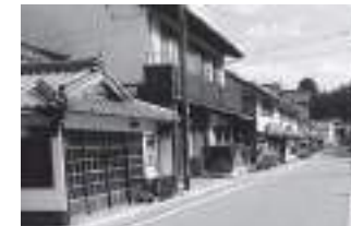
まちなみに合わせて舗装等を工夫 (主要地方道竹田五ヶ瀬線：竹田市)
