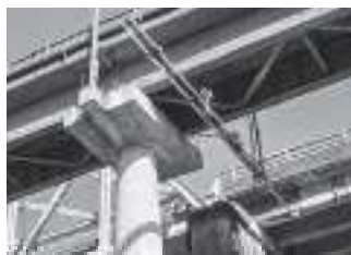
長寿命化計画に基づき橋梁点検の実施 (一般県道中判田犬飼線 犬飼橋側道橋：豊後大野市)
