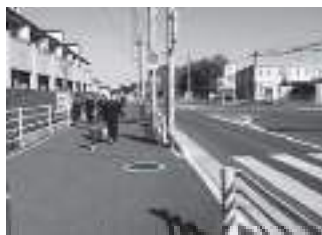
歩道の整備による通学児童の安全確保 一般県道万田四日市線（永添工区）
