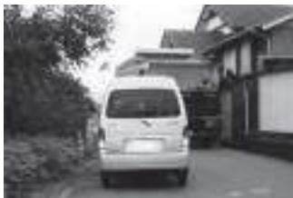
集落と幹線道路を結ぶ道路の幅員狭小箇所 (主要地方道日之影宇目線：佐伯市)
