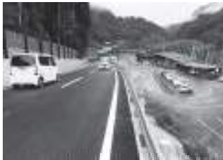
国・県・市町村が連携して計画的に整備を実施 (道の駅「慈恩の滝くす」及び関連道路：珠珠町)
