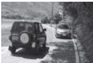
側溝蓋掛けによる路肩広幅 (一般県道日田山国線：日田市)
