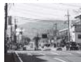
都市景観や防災性の向上に向けた無電柱化の推進（一般国道500号：別府市）
