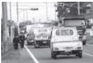
産業活動を支援する道路整備 (主要地方道中津高田線：中津市)
