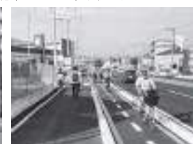
自転車走行空間の分離 (一般国道442号：大分市)
