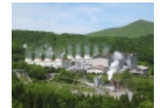
九州電力(株)八丁原発電所
