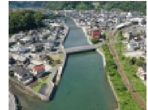
河川改修が完了した津久見川
