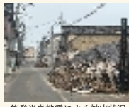
能登半島地震による被害状況
