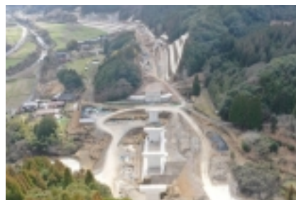
整備が進む中津日田道路（三光本耶馬溪道路）
