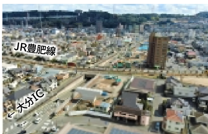
庄の原佐野線（下郡工区）整備状況
