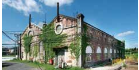
写真提供: 日本製鉄㈱ 九州製鉄所 Photo credit: Kyushu works, Nippon Steel Corporation
