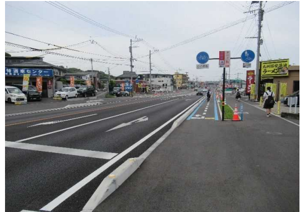
▲ 国道442号 (宗方拡幅) 大分市大字上宗方～大分市大字市
