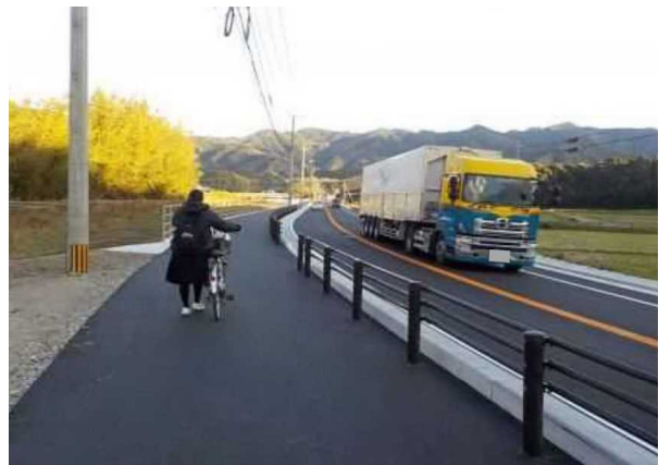
▲ 国道502号 (搔懐工区) 臼杵市搔懐
