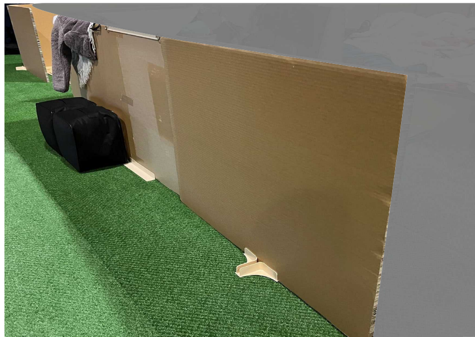
被災者の工夫によって作られた間仕切りと床断熱
