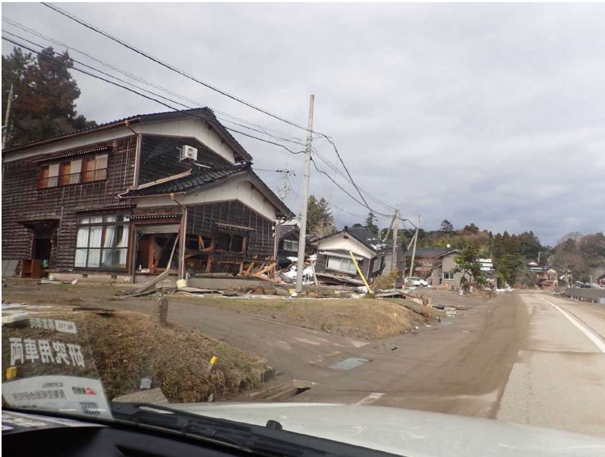
珠洲市三崎地区の津波被害 （震動被害は比較的軽微）
