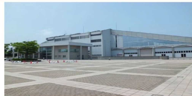
産業展示館4号館 外観
