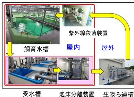
写真2 閉鎖循環式システム
