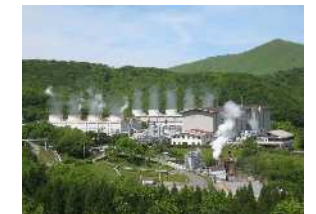
九州電力(株)八丁原発電所
