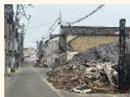
能登半島地震による被害状況
