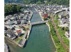
河川改修が完了した津久見川
