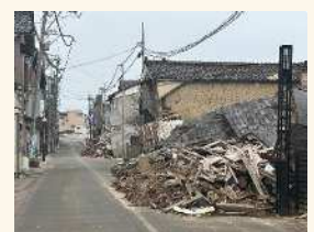
能登半島地震による被害状況
