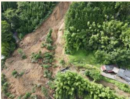
ドローンによる被災箇所調査
