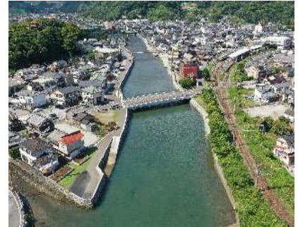
河川改修が完了した津久見川
