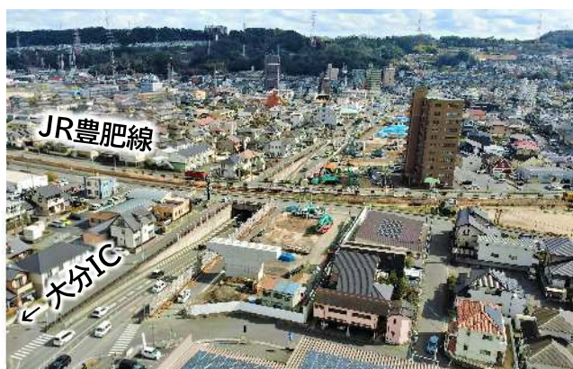
庄の原佐野線（下郡工区）整備状況
