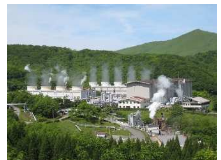
九州電力(株)八丁原発電所
