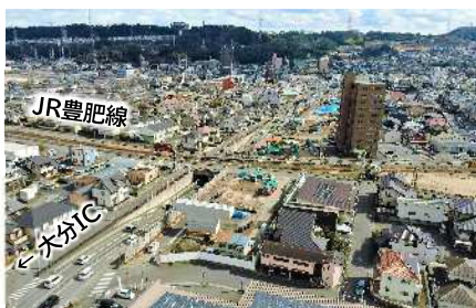
庄の原佐野線（下郡工区）整備状況
