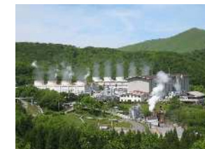
九州電力(株)八丁原発電所
