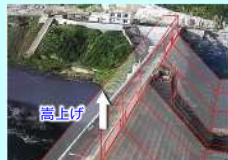
安岐ダムの再生
