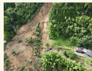
ドローンによる被災箇所調査
