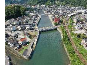
河川改修が完了した津久見川
