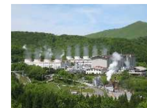
九州電力(株)八丁原発電所
