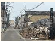
能登半島地震による被害状況
