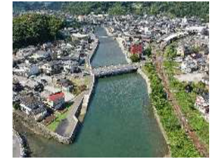
河川改修が完了した津久見川
