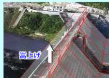
安岐ダムの再生
