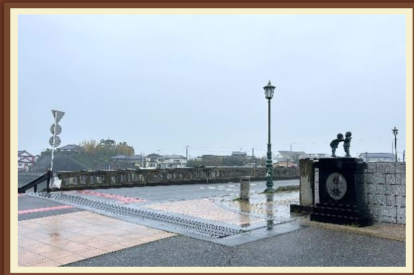
桂桥 电影结尾，敦也奔跑而过的桥梁
