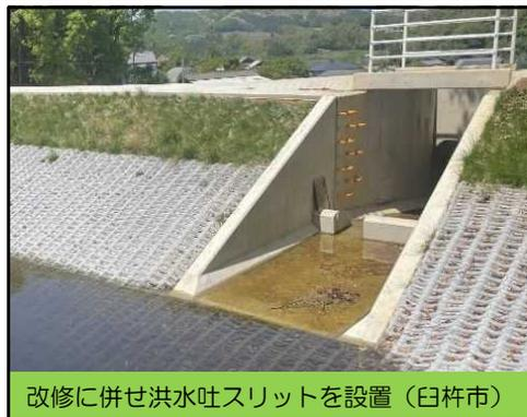
改修に併せ洪水吐スリットを設置 (臼杵市)
