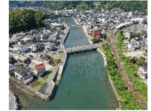
河川改修が完了した津久見川
